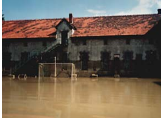
Zalane warsztaty szkolne przy ul. Zamkowej, powódź 1997r.
