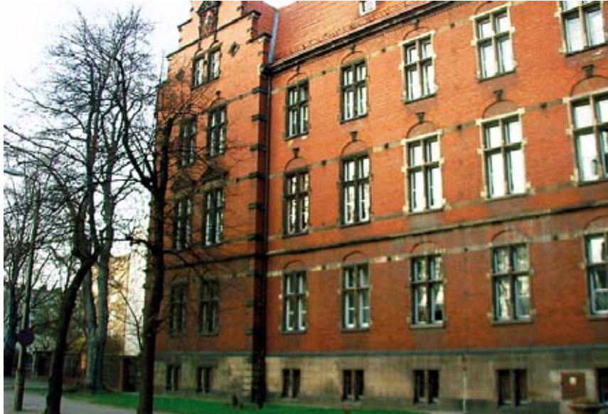
Fragment frontowej części budynku.
